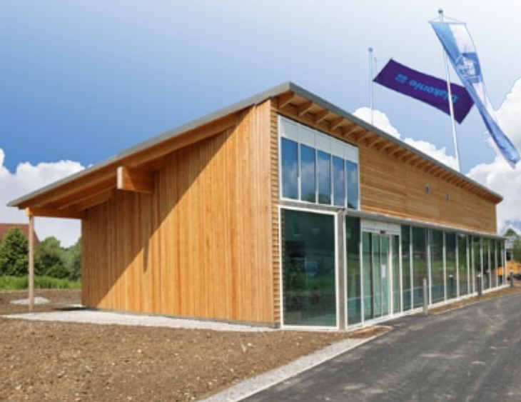
Neubau der Förderstätte mit Unterstützung der Förderstiftung Herzogsägmühle
